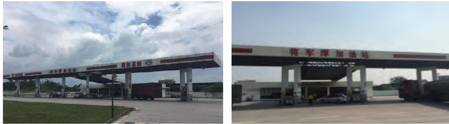
广东泗喜能源有限公司油站
